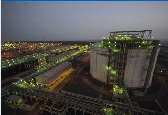
LNG Petronet (Gas Terminal)
